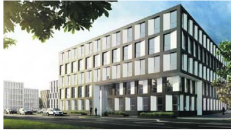
Für Eastsite IV wurde gerade Richtfest gefeiert, für Eastsite V (links im Hintergrund) soll im September der Grundstein gelegt werden.
