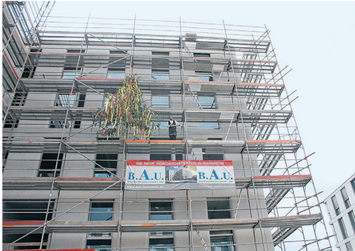
„Er fraß ein maßgenaues Loch, bevor er abends weiterkroch“, erinnert sich Dachdeckermeister Michael Regenauer in seinem Richtspruch für Eastsite V an den Baggereinsatz zu Beginn der Bauarbeiten an dem Bürogebäude in Neustheim. BILD: DEN
