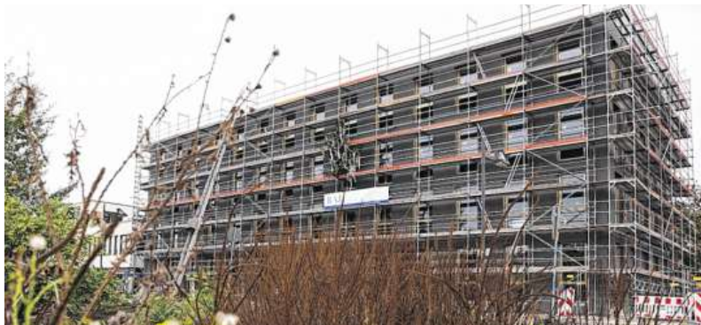
Wenn die Fassade ganz fertig ist, wird sie „ein Hingucker in Anthrazit und Blassgold“, so Bauherr Peter Gaul über das Bürogebäude „Eastsite VIII“.
