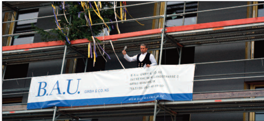
Dachdeckermeister Michael Regenauer beim traditionellen Richtspruch und -trunk
