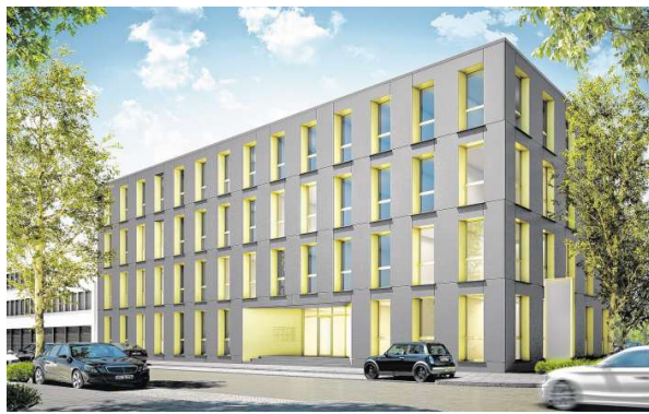
Endspurt: Schon im Juni sollen die Mieter die Eastsite VIII beziehen.
