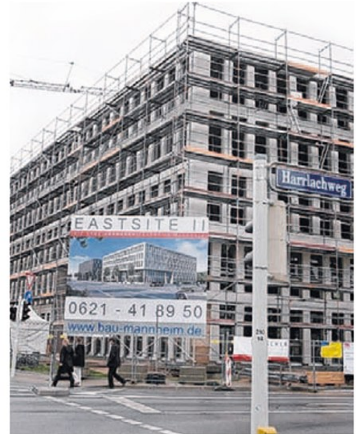
Rohbau und Dachstuhl von Eastsite II sind fertig.
