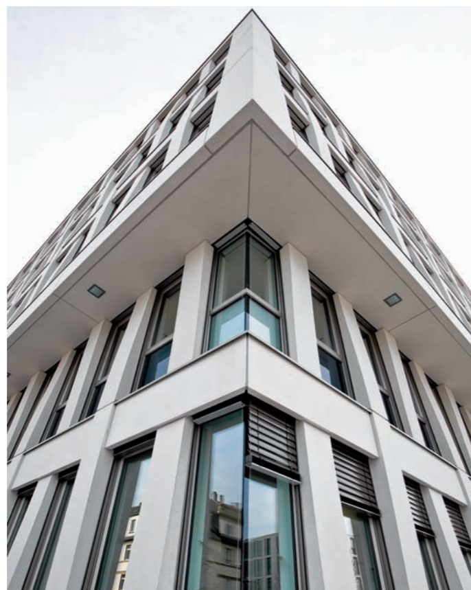
Viele Firmen zieht es in die Eastsite, hier im Bild Gebäude II.
