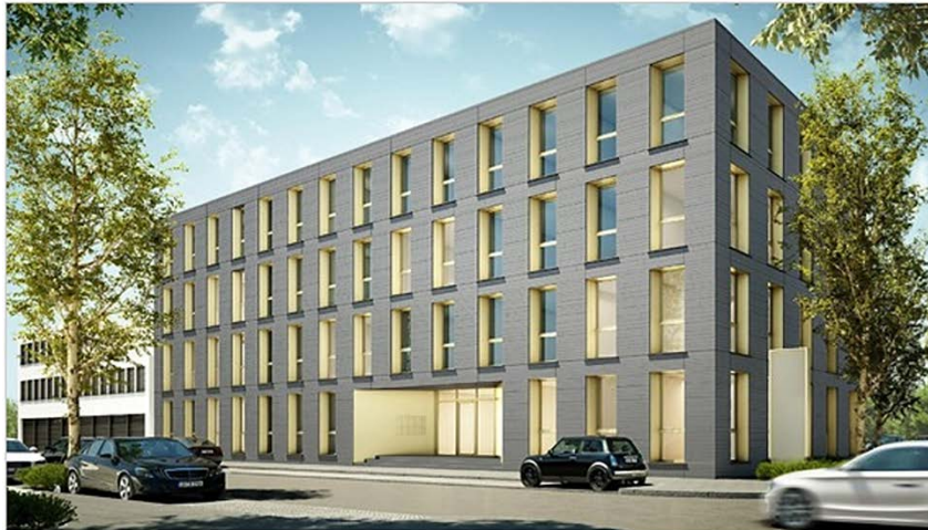
RC-Beton und Textilbeton machen das Bürogebäude Eastsite VIII energie- und materialsparend. Weitere vier Gebäude sollen den Büropark komplettieren.
