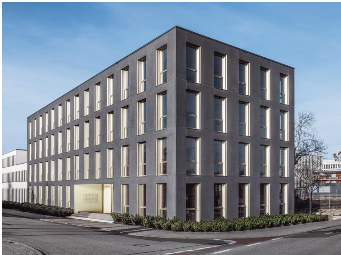
Bürogebäude Eastside VIII
