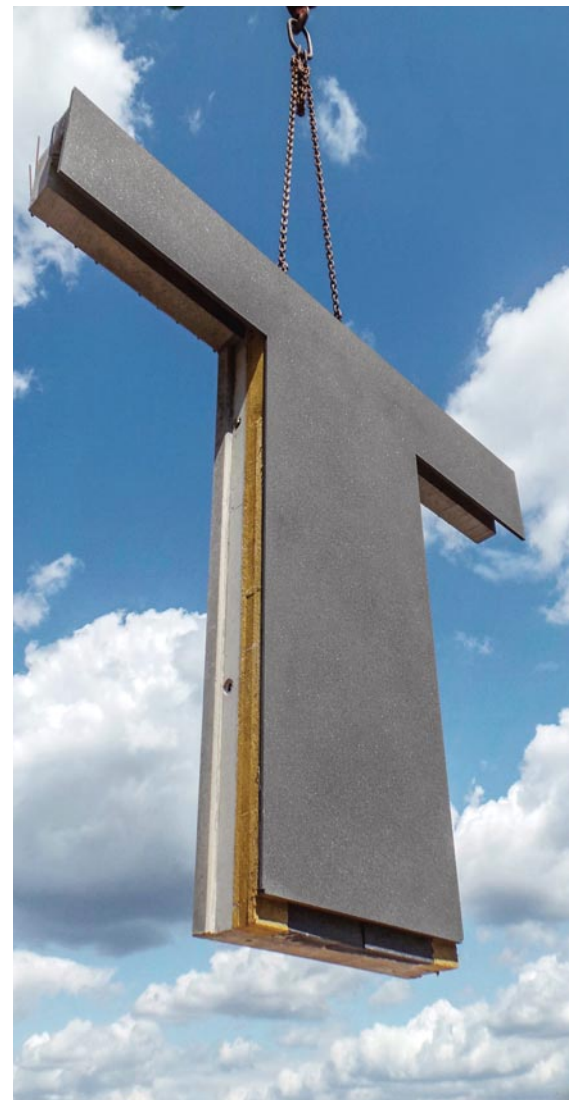
Sandwichfassadenelement mit Textilbewehrung
