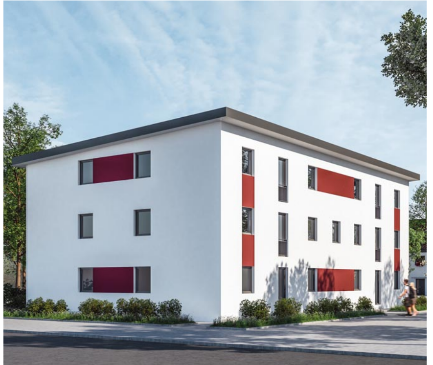
Schnelle Wohnunterkunft „Punkthaus“ von Dreßler Bau
