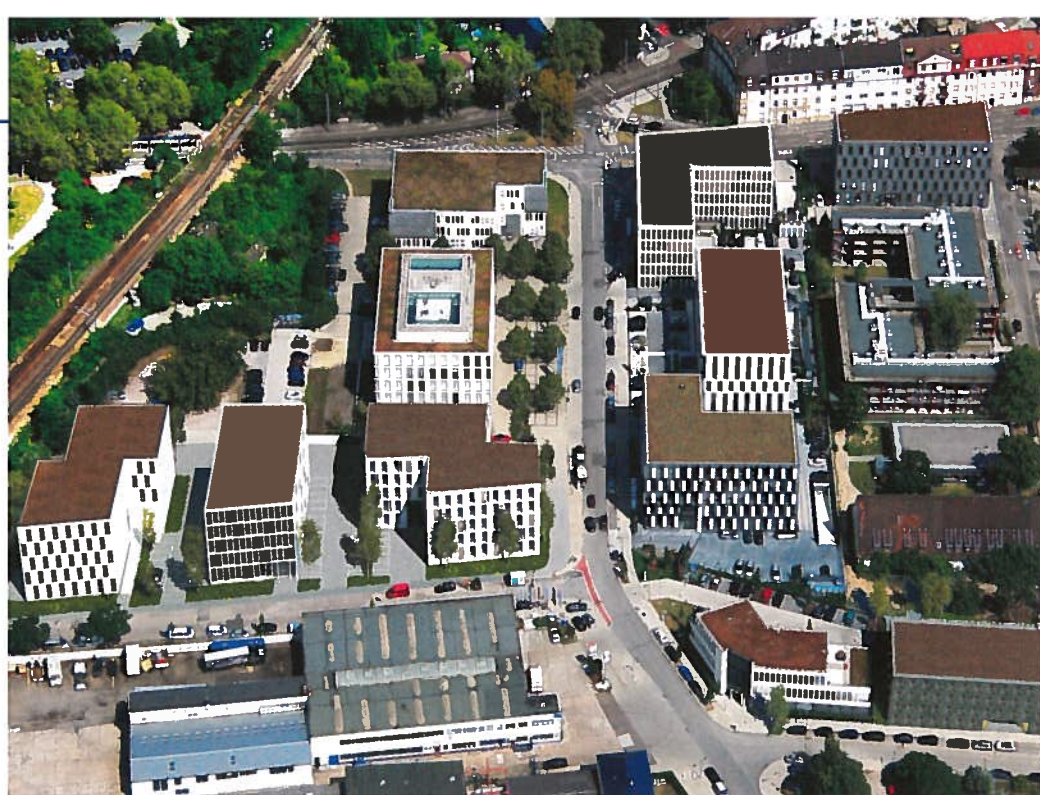
Im Büropark Eastsite hat die B.A.U. aktuell acht Gebäude errichtet. Eastsite VIII steht kurz vor der Fertigstellung.
